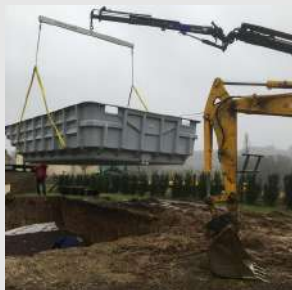
2. Livraison et pose de la piscine
