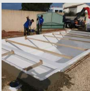
5. Création de l'assise béton
