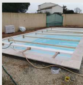
6. Pose des margelles* et mise en eau
