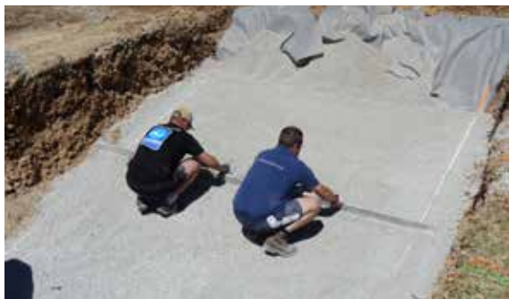
PRÉPARATION ASSISE DRAINANTE
