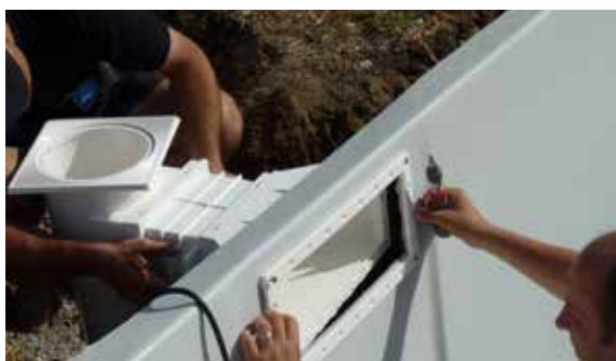
MISE EN PLACE DES PIÈCES À SCELLER
