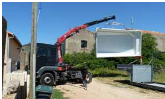
LIVRAISON DE LA PISCINE
